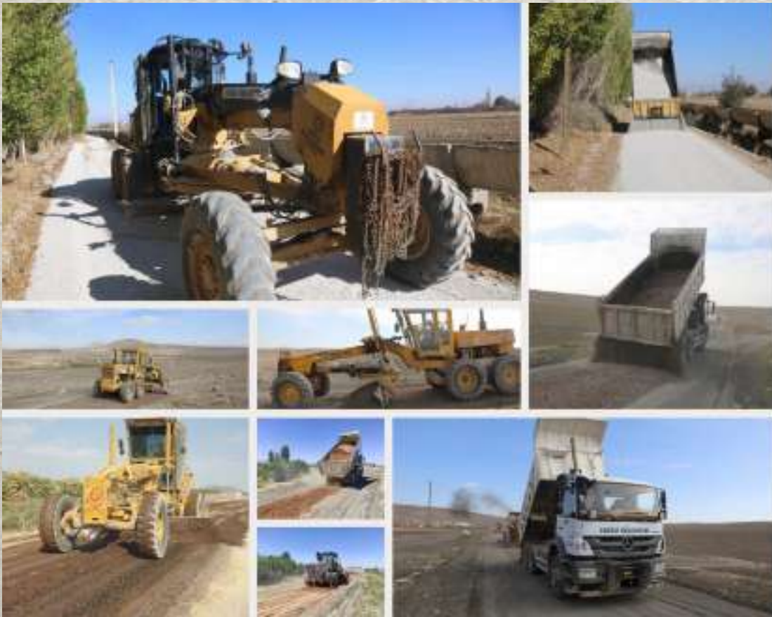
Fen İşleri Müdürlüğü Ekiplerimiz tarafından 58.578,03 ton alt temel filler malzemesi serilmiştir.
