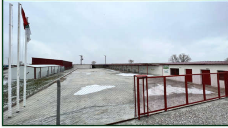
Sıfır Atık Projesi kapsamında, 1.Sınıf Atık Getirme Merkezi 2022 yılında faaliyet geçmiştir.
