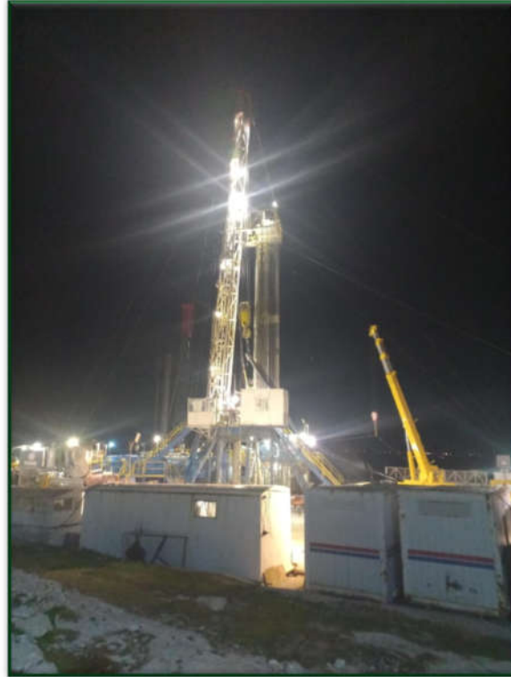
Akhüyük Mahallesi'nde bulunan Akhüyük Termal Tesisinde, Jeotermal Sondaj kuyusunun faaliyetleri devam etmektedir.
