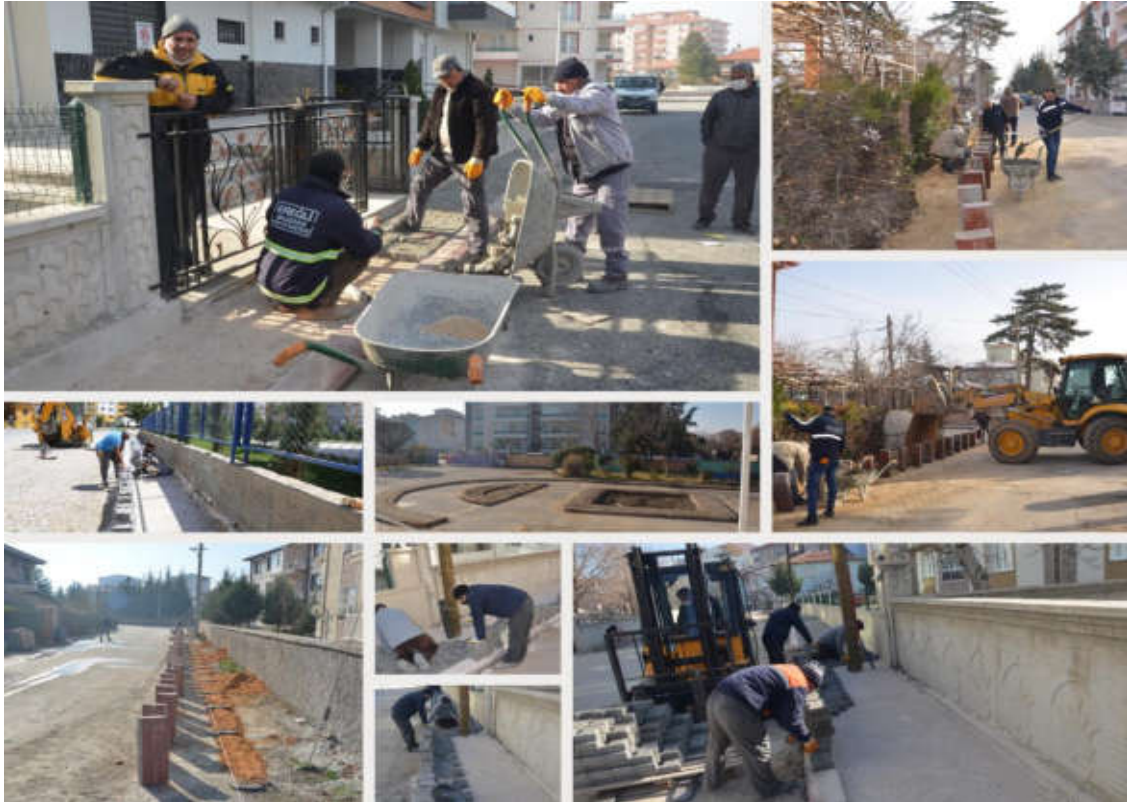
İlçemiz merkez ve mahallelerinde kaldırım ve bordür çalışmaları yapılmış ve yapılmaya devam etmektedir.
